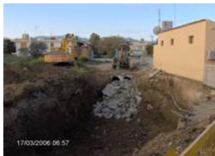
Εικόνα 19 Κατασκευή οχετού ομβρίων υδάτων
