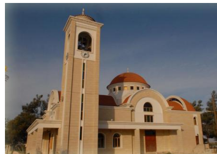
Εικόνα 12 Εκκλησία Αγία Παρασκευή
